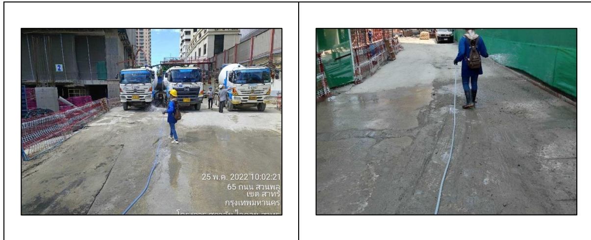
ภาพที่ 10 คนงานฉีดพรมน้ำบริเวณพื้นที่ก่อสร้าง
