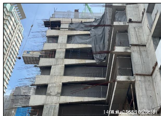
ภาพที่ 23 กำแพงกันเสียงบริเวณตั้งแต่ชั้น 2 ของอาคาร
