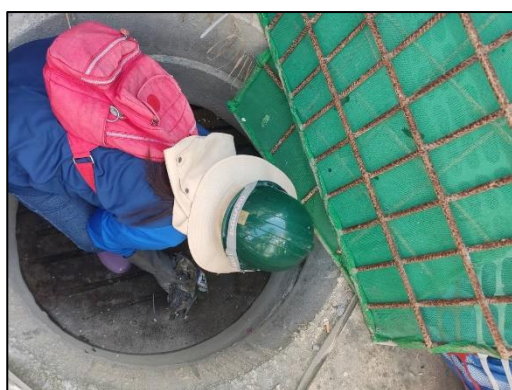
ภาพที่ 30 บุคลากรถอนดินที่สะสมในบ่อพัก
